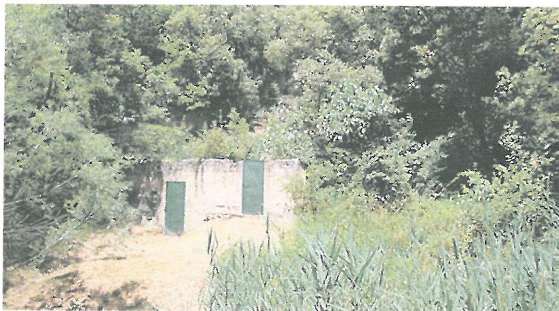
VUES EXTERIEURES DU CAPTAGE ET DU MUR DE CLÔTURE DU PPI au premier plan, en bas à droite, : végétation du ruisseau d'Auzigue (cl. ARS DT 30)
