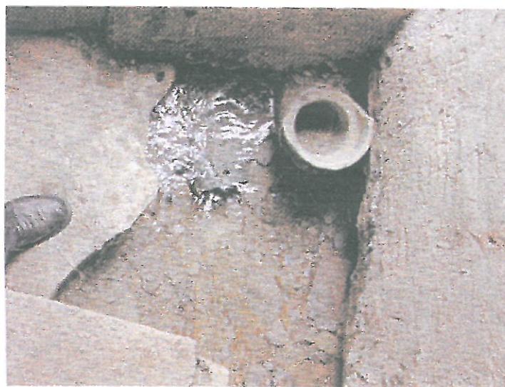
VUES INTÉRIEURES DU CAPTAGE (cl. GINGER)
