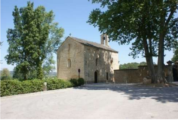
Chapelle Saint Julien: vieux bâtiment en pierres propice aux chauves-souris. De vieux arbres au sein de la propriété présentent également un intérêt écologique.
