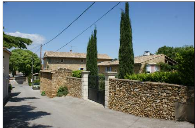
Quand les bâtiments ne sont pas implantés à l'alignement, des murs de clôtures en pierres prolongent les continuités bâties, donnant corps à la rue.
