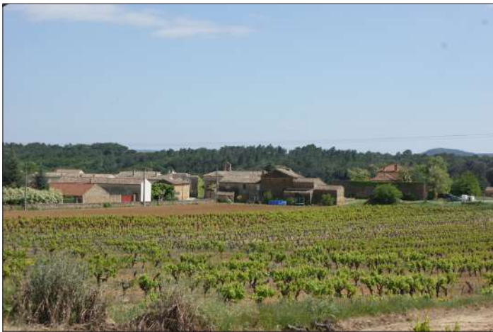
Depuis le Nord, le hameau se détache aussi nettement, mais les façades «arrière» des bâtiments sont moins avenantes.
